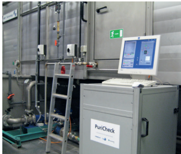
Bild 3. Direkte Partikelmessung am letzten Spültank einer industriellen Teilereinigungsanlage
